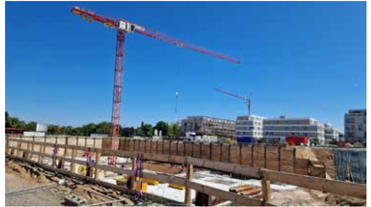
In der Baugrube für die Activ-Plaza und das Bürger- und Kulturhaus wird aktuell an der Tiefgarage gearbeitet.
